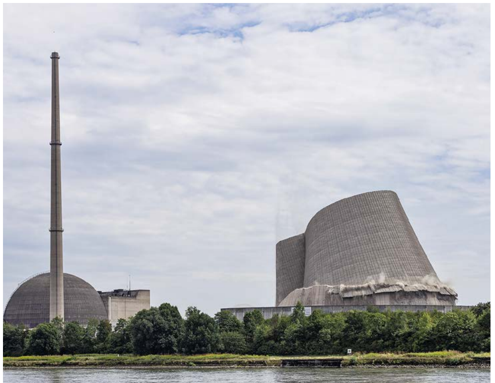
Abbruch des Kühlturms des stillgelegten Atomkraftwerks Mülheim-Kärlich im Sommer 2019.
